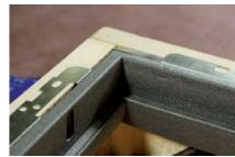
Assenza di ponti termici La cornice isolante ottimizza l'isolamento attorno al perimetro della finestra. Si compone di uno speciale profilo in metallo con uno strato di poliuretano.
